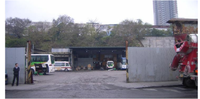
汽車修理工場 VEHICLE REPAIR WORKSHOP
