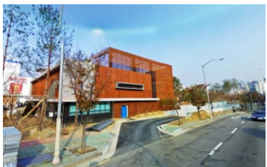
IWHF 綜合廢物 處理設施
