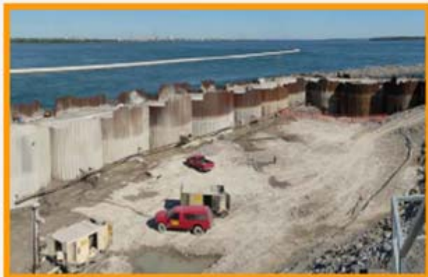
圍堰 - 明挖回填式隧道 Cut-and-Cover – Cofferdam
