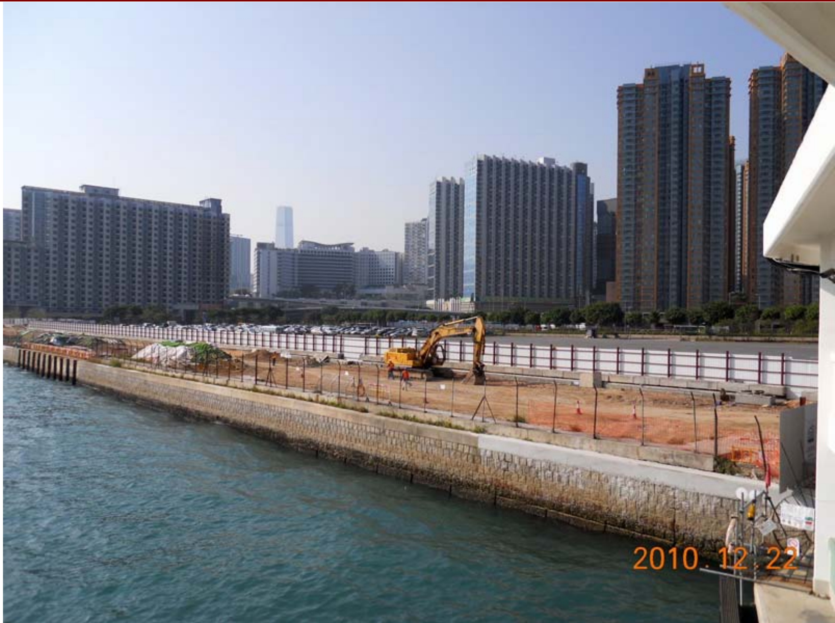
Progress Photo – Earthworks 進度照片 – 土方工程
