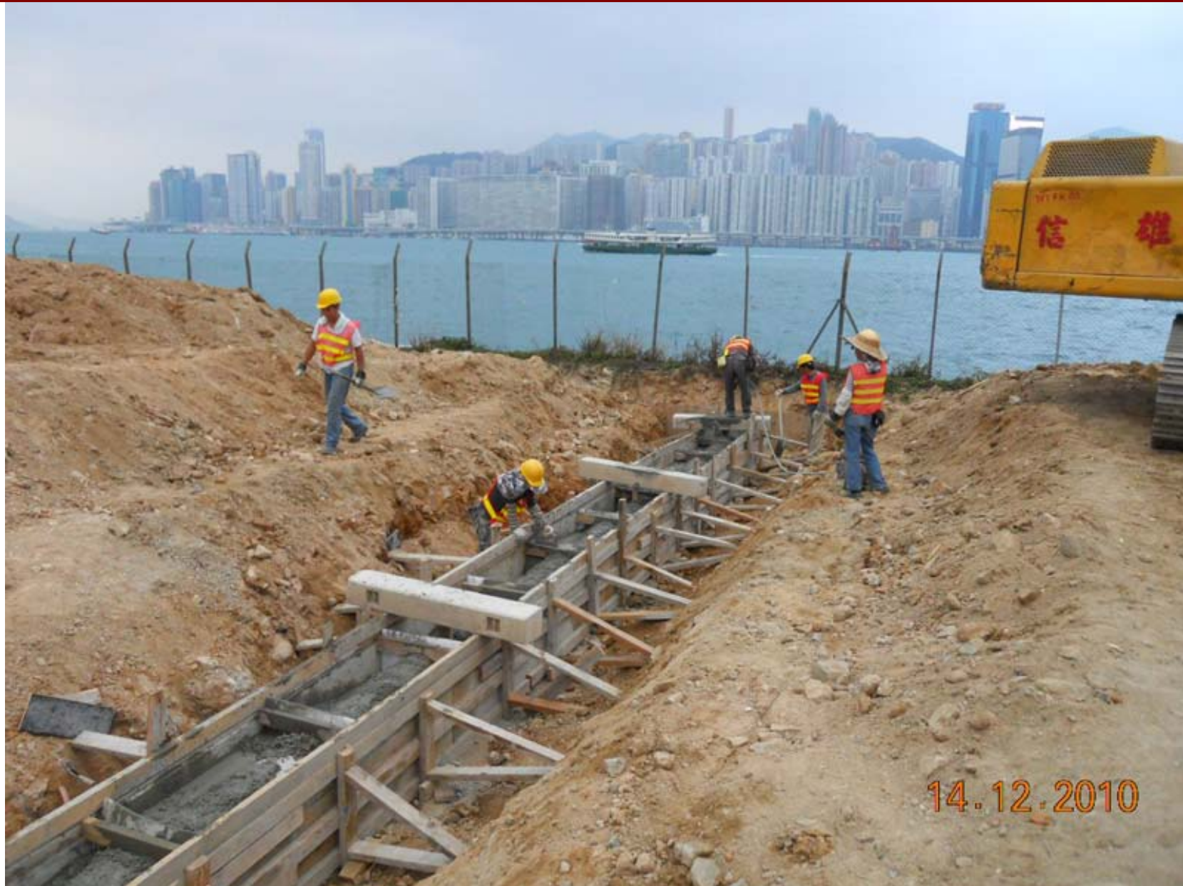
Progress Photo – Drainage Construction 進度照片 – 渠務工程
