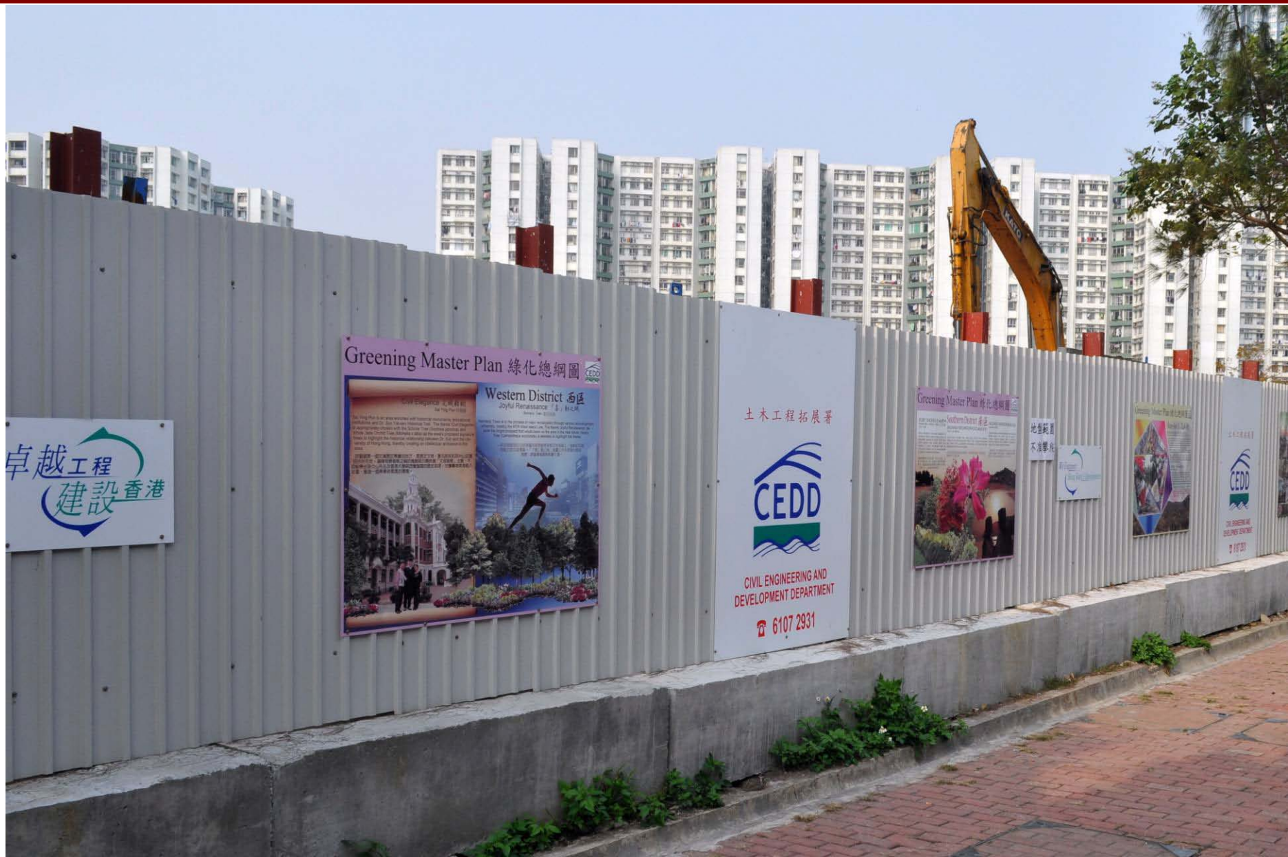
Progress Photo – Temporary Hoarding 進度照片 – 臨時圍板
