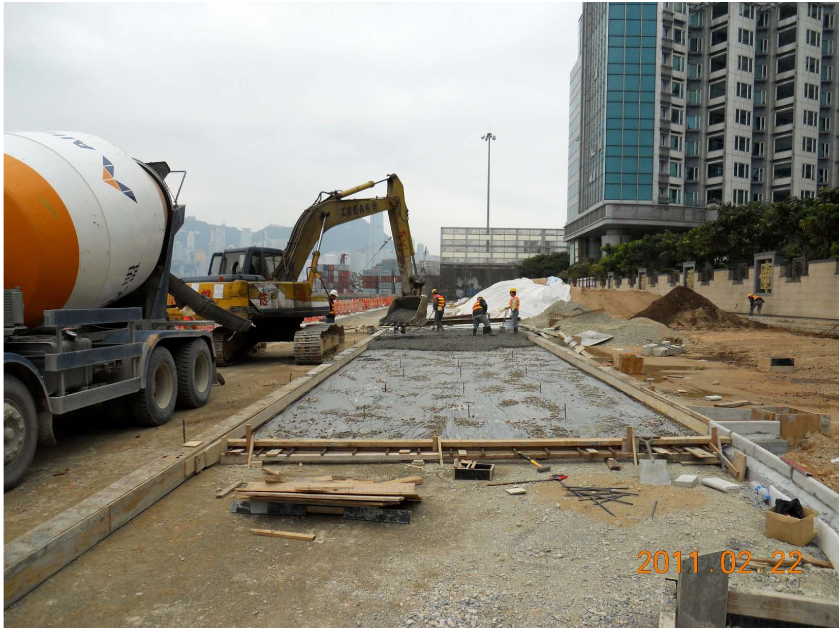
Progress Photo – Concrete Pavement Construction 進度照片 – 建造混凝土路面
