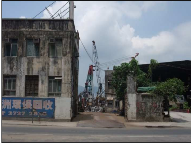
Recycling Station 回收站
