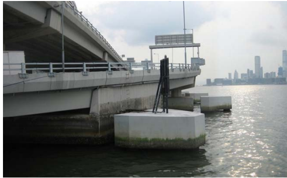
東區走廊現有狀況 IEC: Existing Conditions
