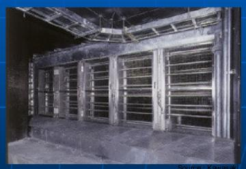
可以根據須處理的空氣流量彈性組合多個組件單位 Different Combinations of Modular Units to Suit Volume of Air to be Treated 18
