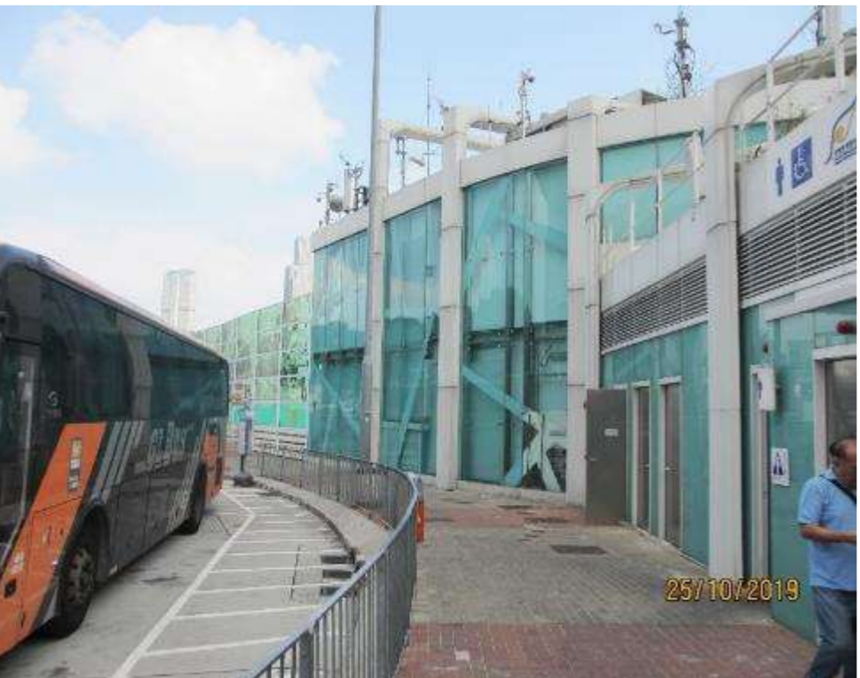
1. 博覽道東公共廁所 Expo Drive East Public Toilet
